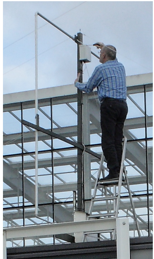
Afbeelding 6. de aanpasbox installeren. De witte kabel is voor de anti-condens verwarming en de relais omschakeling.
